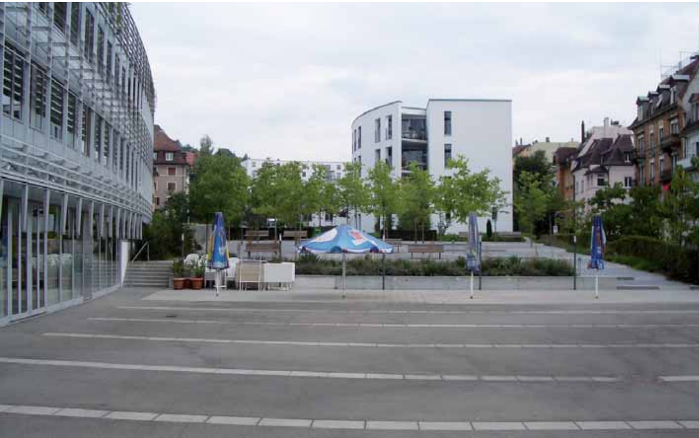
April 1998: Der Bahneinschnitt Wipkingen ist verschwunden. Auf dem gewonnenen Land wurden die Wohnbauten «Sidlig über de Gleis» errichtet. Das Überdeckungsbauwerk besteht aus pfahlfundierten Wänden und einer vorgespannten Rippendecke. Die Hauptabmessungen sind: Höhe 5.8-7.5 Meter, Breite 11-28 Meter, Länge 240 Meter. Gesamtbausumme: 22 Millionen Franken.
