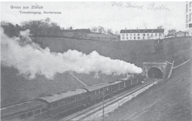
Dampfzug im Bahneinschnitt um 1903. (Postkarte: Sammlung Richard Limburg) Das Ensemble Oerliker Tunnel, Bahneinschnitt, Damm und Eisenbrücke über die Limmat ist ein bedeutendes Denkmal der Eisenbahntechnik des 19. Jahrhunderts. Die 1856 fertig gestellte Strecke gab der damaligen Ingenieurkunst ungewohnte Aufgaben zu lösen.
