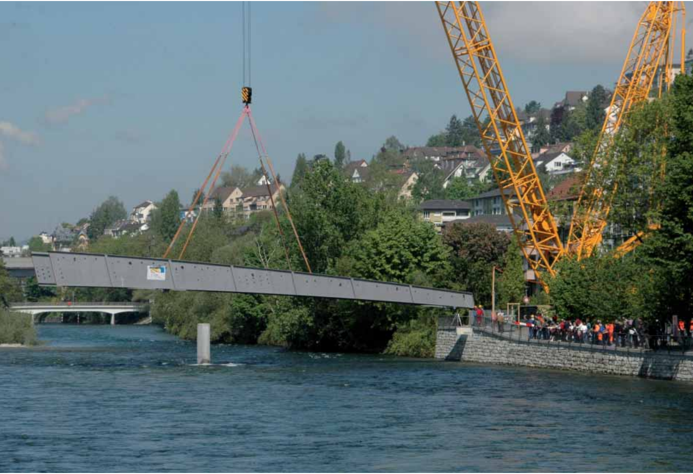
2004: Neugestaltung des Limmatufers beim GZ Wipkingen. Eine Treppenanlage mit Sitz- und Liegestufen erlaubt den direkten Zugang zum Wasser. Anlässlich des 50-Jahr-Jubiläums des Gemeinschaftszentrums Wipkingen konnte dieser neue Park eröffnet werden und wurde vom Publikum begeistert aufgenommen. Die Stadt verpasste der Grünfläche den Namen «Kattunpark», was die Bewohner in alter Tradition nicht goutierten (vergleiche die Reaktion bei der Namensgebung Bahnhof Letten anno 1894!). Der Quartierverein setzte mit Unterstützung der Gemeinderäte Kreis 10 den heutigen Namen Wipkingerpark durch. 2005 wurde die Brücke montiert. Seither hat das GZ deutlich mehr Besucher aus Züri-West.
