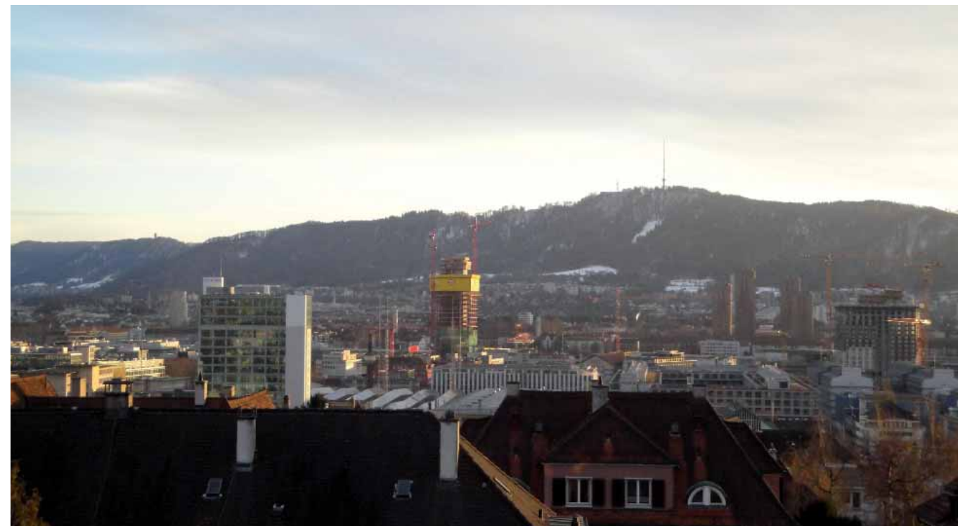
Seit Anfang der Neunziger können die Wipkinger aus luftiger Höhe den Bauboom im Industriequartier beobachten: Steinfelsareal, Überbauung Limmatwest, Kino Abaton, Technopark, Puls 5 und Prime Tower (Bildmitte, Höhe ca. 80 Meter, bei Fertigstellung 126 Meter – «a place in space».)
