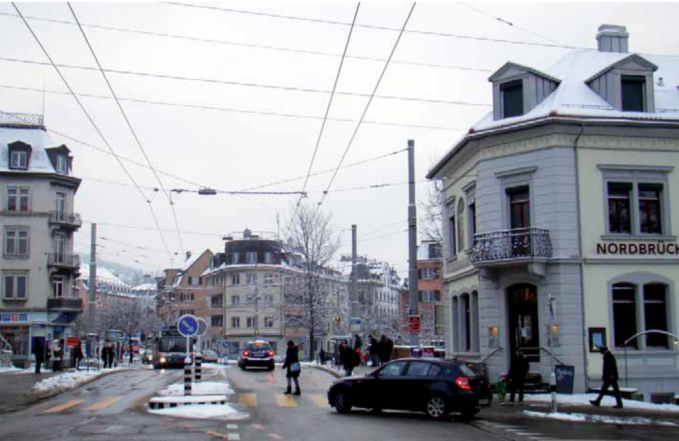
2010: Der Bahneinschnitt ist seit gut 20 Jahren zugebaut. Der Jugendstil-Schriftzug des «Restaurant Nordbrücke» ist verschwunden, aber der Treffpunkt ist gerettet!
