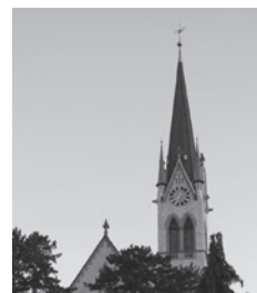
Kirche Wipkingen Wibichstrasse 43 8037 Zürich
