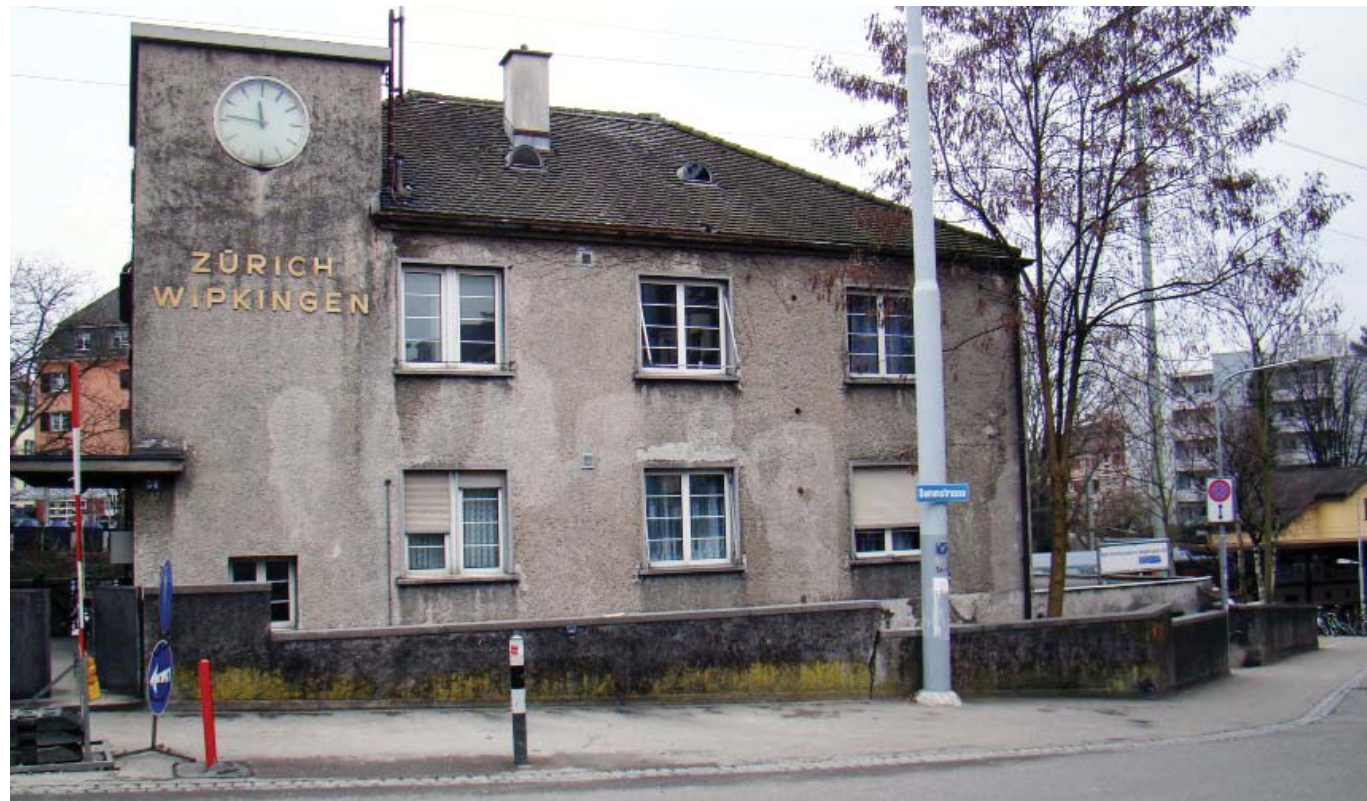
Hoffentlich bald schon um einen Stock höher und für Quartieraktivitäten nutzbar: Das Bahnhofgebäude trägt zur Aufwertung des Röschiachplatzes als Quartierzentrum bei.
